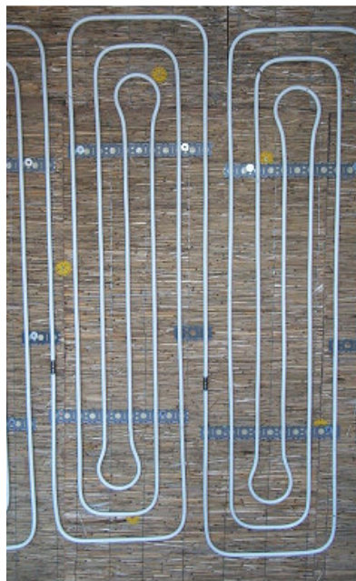
2 Klimaregister, die Profi-Lösung für Neubau und Sanierung von Massivhäusern, werden verputzt.
