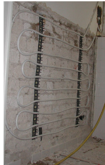
3 Das zu verputzende Klimarohrsystem ist vom Material her günstiger, aber aufwändiger in der Montage.
