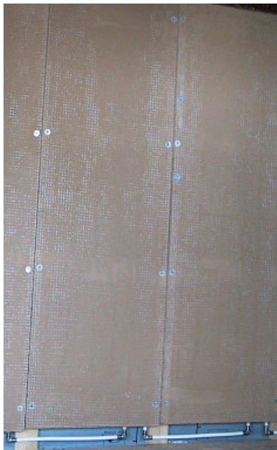
1 Klimatelemente sind vorgefertigte Platten aus Lehm, die im Trockenbau verarbeitet werden.
