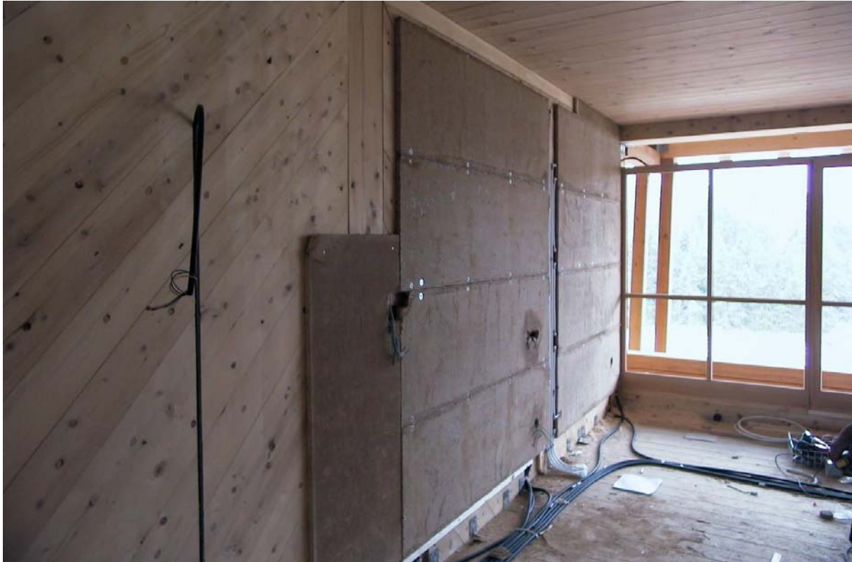
WEM® Klimaelement – Wandheizungs-Fertigbauteil aus Lehm Rohmontage Hotel Urthaler, Seiseralm Tirol
